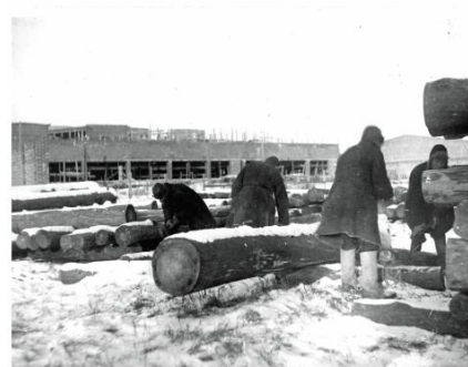
Строительство льночесальной фабрики. 1931 г.
